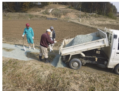
農道砂利敷き状況
