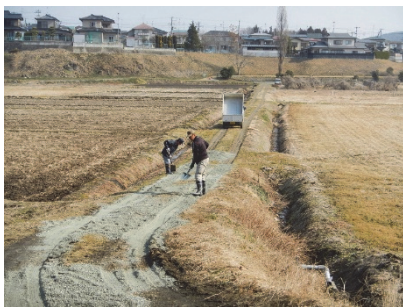
農道砂利敷き状況
