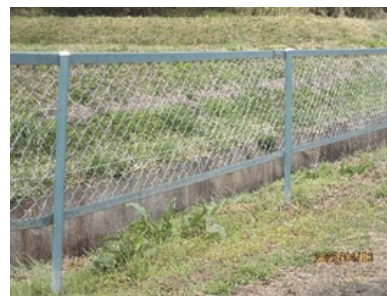
ネットフェンスの改良作業
