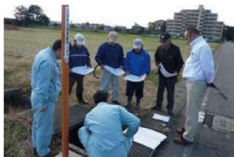
施工前に図面を使って現地で業者から説明を受ける
