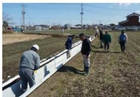
更新した水路の完成検査を行う
