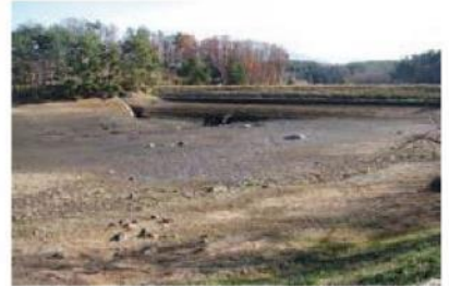
常時水面下にある部分は水抜き時に機能診断と補修を行うとよい
