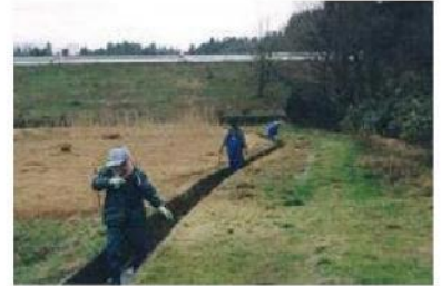
点検で問題のあった箇所は水路のなかに入って内側の状況も丁寧に確認してみましょう
