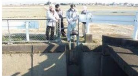
水路のゲート更新の前に業者と現地で確認を行う
