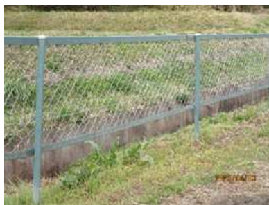
ネットフェンスの改良作業
