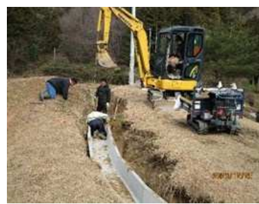
地域住民による水路装甲作業
