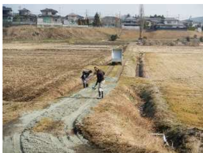
農道砂利敷き状況
