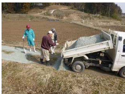
農道砂利敷き状況
