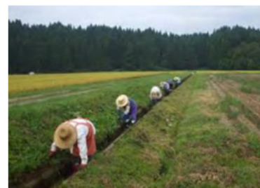
水路の泥上げ
