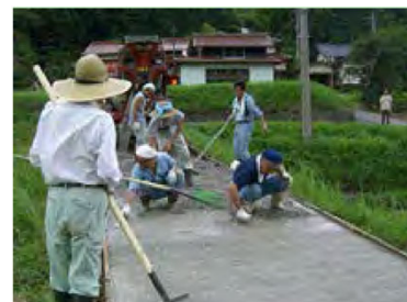
農道のコンクリート舗装
