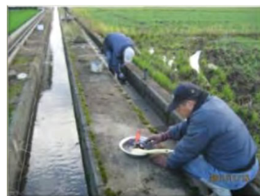
自主施工による目地補修
